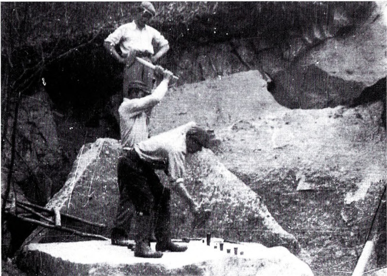
55. Prace w kamieniołomie w celu pozyskania materiału do budowy.
