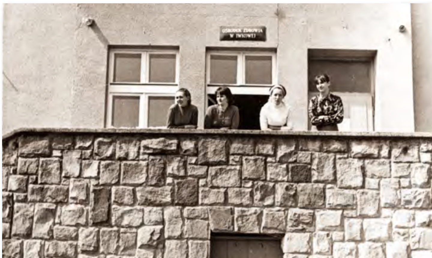
6.53. Ośrodek Zdrowia w Iwkowej w trakcie budowy – archiwum GBP w Iwkowej – kolekcja Fotografie , fot. Ludwik Szot – początek lat 60.
