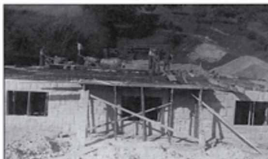
Budowa budynku Urzędu Gminy w Iwkowej, lata 60.
