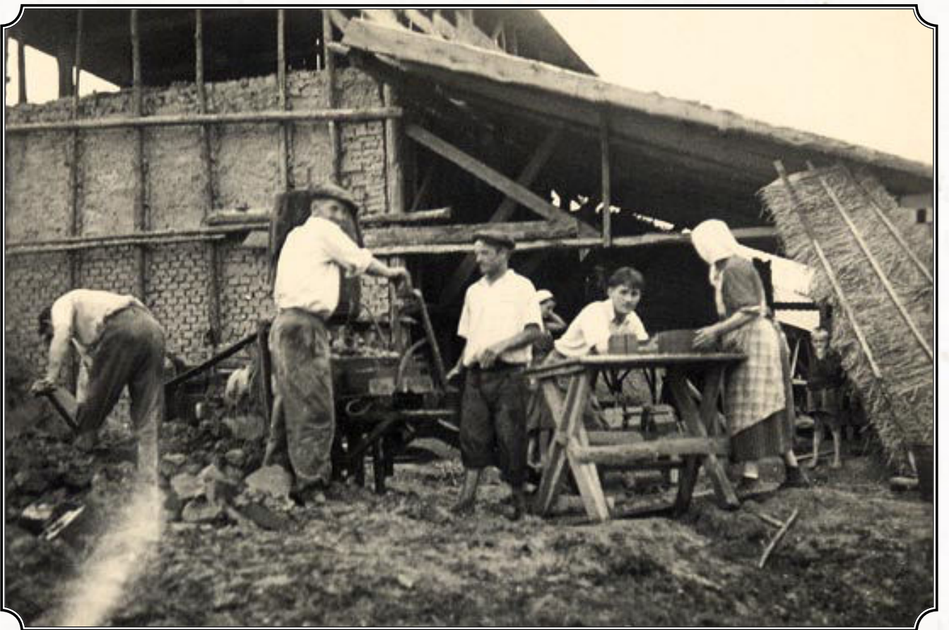
Cegielnia na Dziegiełowie – wypalanie cegieł dla potrzeb własnych; podczas produkcji cegły liczyła się każda para rąk – Iwkowa – początek lat 60.; ze zbiorów H. i J. Dziegłóm.
