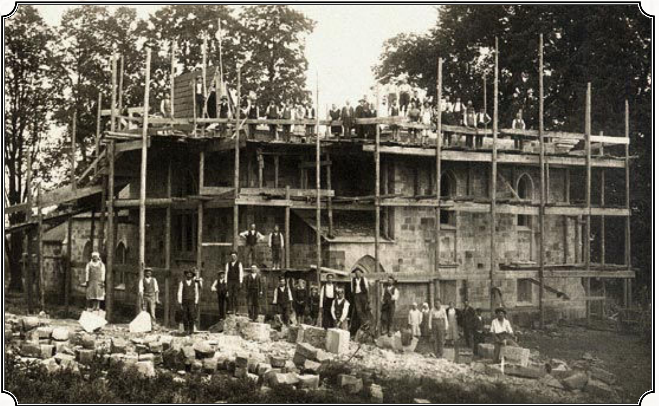
Kościół parafialny w trakcie budowy – początek lat 30.; ze zbiorów ks. S. Tokarskiego.
