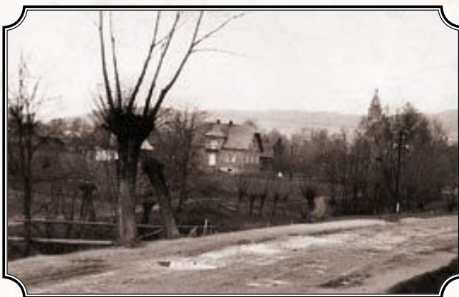
Inkova – II połowa lat 60. – widok z drogi głównej przed mostem na „krzyżówce”. Drewnianą ławę na rzece Beli pod koniec lat 70. zastąpiono betonowym mostem, fot. L. Szot; ze zbiorów S. Szota.
