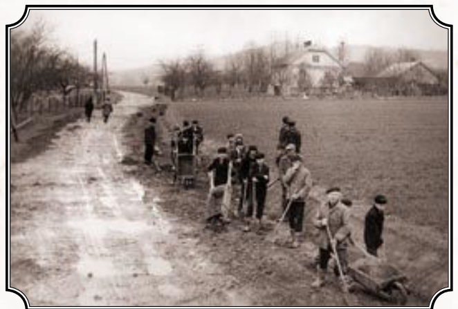
Budowa drogi Wojakowa – Porąbka Inkonska – 1967 rok, fot. S. Klimek; ze zbiorów Cz. Klimek.
