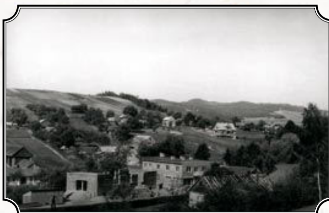
Iwkowa – połowa lat 60. – budowa sali widowiskowej (dzisiejszy budynek UG). W fundamencie budynku wmurowano dokument mówiący o jego fundatorach – rodzinie Szczepańskich z USA, fot. L. Szot; ze zbiorów Z. Serafin.
