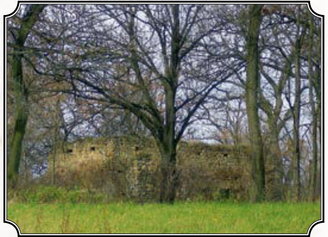
Kąty – ruiny spichlerza obok zabytkowego dworku oraz pozostałości zabudowań gospodarczych w dworskim kompleksie – 2010 r., fot. B. Klimek; ze zbiorów GBP w Iwkowej.
