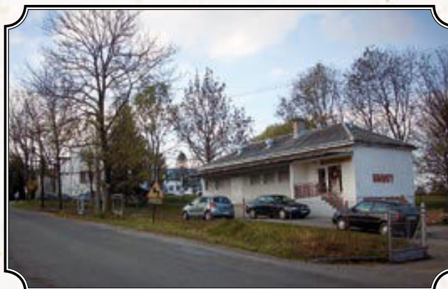
Porąbka Iwkowska – centrum. Na pierwszym planie budynek, w którym znajdują się zlewnia mleka, kwiaciarnia i fryzjer – 2010 r., fot. A. Mikołajczyk; ze zbiorów GBP w Iwkowej.
