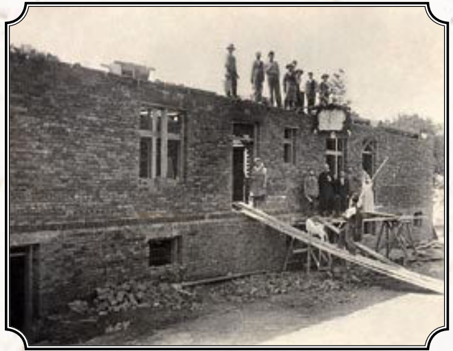
Budowa plebanii w Iwce w latach 1935-1938. Na zdjęciu ks. Jan K. Chmiel w otoczeniu ekipy budowlanej z Jadownik, z lewej siostrzenica księdza – Maria (po mężu Szot); ze zbiorów H. Stanuch.
