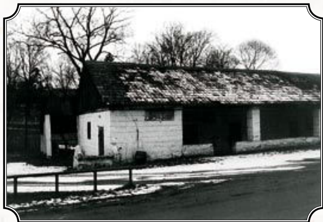
Iwkowa – centrum. Budynek skupu żywności (tzw. „spęd”) – obecnie jest tu odnowiony skwerek – 1995 r., fot. Z. Klimek; ze zbiorów GBP w Iwkowej.
