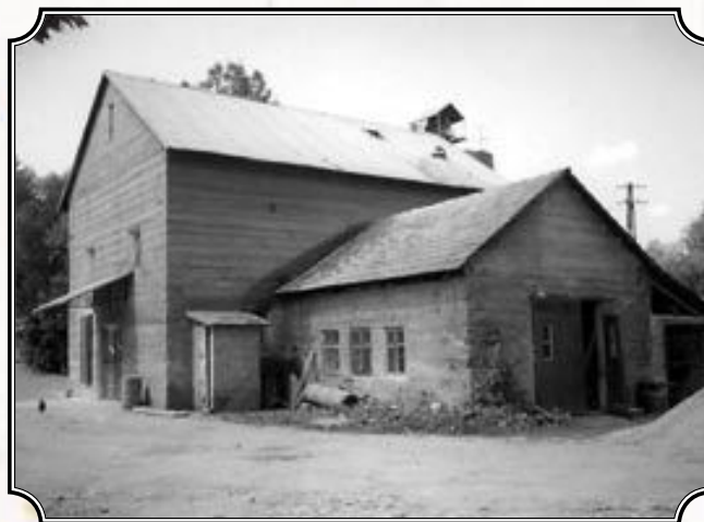
Jedyny działający na terenie gminy młyn – w Kątach – należący do rodziny Hołystów, założony w latach 30., na zdjęciu budynek z lat 90. z charakterystyczną betonową ścianą, fot. A. Hołyst; ze zbiorów A. i M. Hołystów.
