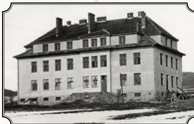
Osrodek Zdrowia w Iwkowej w budowie – początek lat 60., fot. L. Szot; ze zbiorów GBP w Iwkowej.
